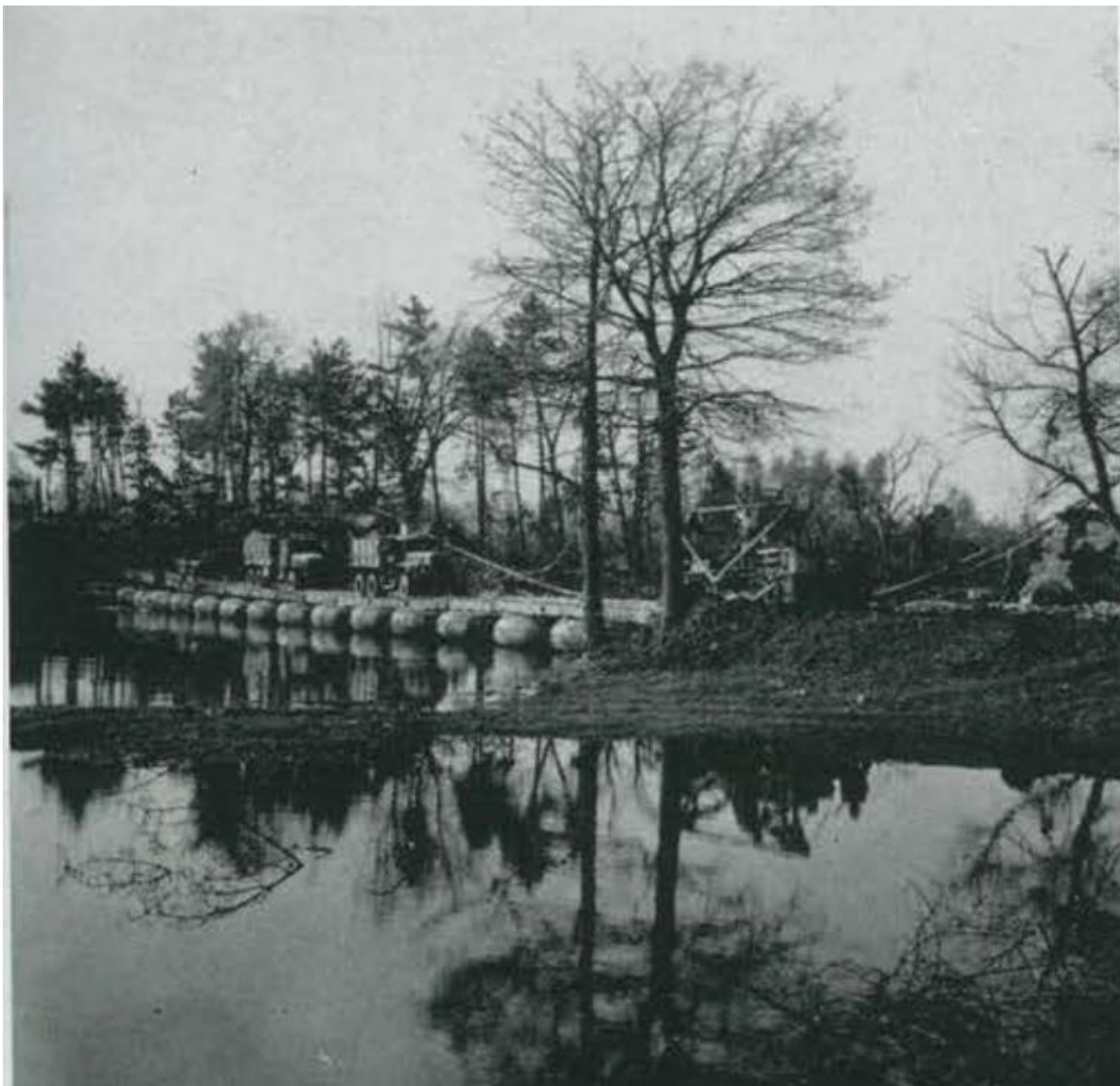
Abbildung 18 Die Brücke über die Agger steht. Fahrzeuge überqueren den Nebenfluss der Sieg. Haltetaue auf der Bergseite.
