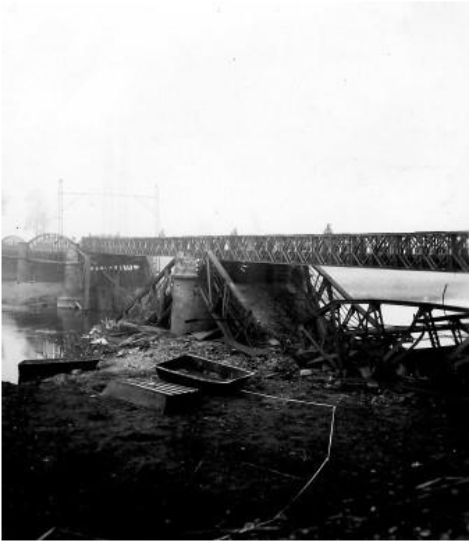
Abbildung 12 Die Eisenbahnbrücke bei Siegburg. Am Ufer zurückgelassene „Assault Boats“. Foto William Bahlke
