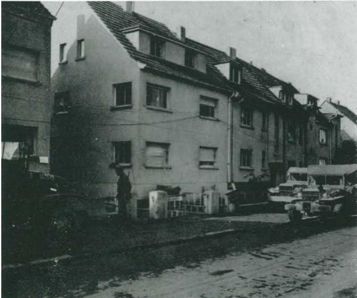
Abbildung 16 Kommandozentrale (CP) des 124th Armored Engineer Bataillion (Pioniere) der 13th Armored Divion (Panzerdivision) in Siegburg für wenige Tage. Alte Poststrasse Nummer 24. Siehe 65er Nachrichten Heft 206 2/2023 p.59ff
